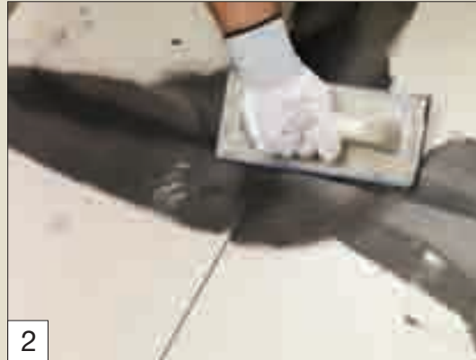
Очистка по завершению строительных работ
